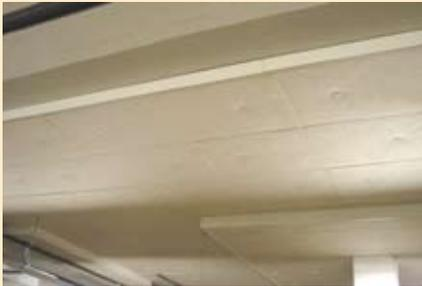
SAGLAN SB 55 K Deckenplatten mit sichtbaren Isolierdornen
