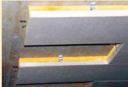
SAGLAN SB 55 K Deckenplatten mit Haltekrallen für die verdeckte Montage. Die Krallen sind nach der Montage nicht mehr sichtbar.
